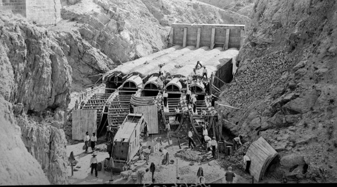
Sustitución del antiguo viaducto metálico de Carricalejo, situado en el p. k. 428,670 de la línea Chinchilla-Cartagena, por un terraplén. Año 1925.
