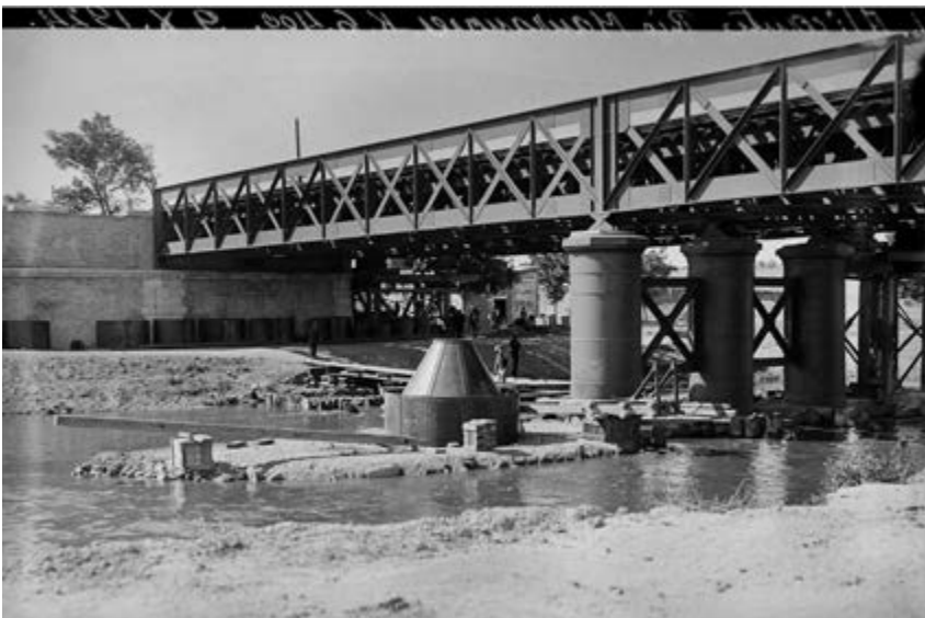
Trabajos de cimentación por aire comprimido de los pilares de hormigón del puente sobre el río Manzanares, en el p. k. 6,400 de la línea de Madrid-Alicante. Año 1924.
