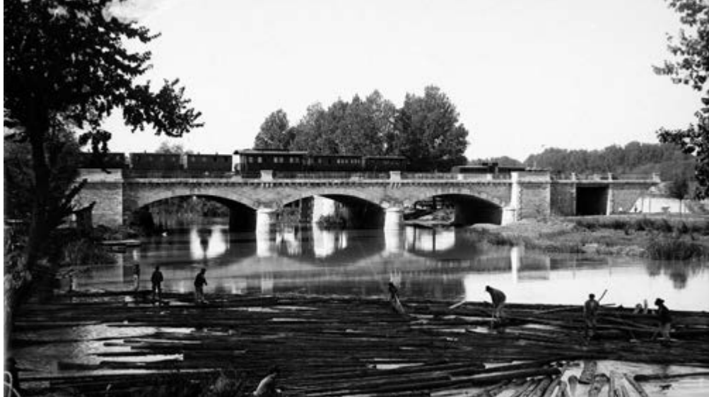
Gancheros transportando maderadas por el río Tajo, a su llegada al puente de fábrica en Aranjuez, en el p. k. 47,838 de la línea Madrid-Alicante. Año 1919.
