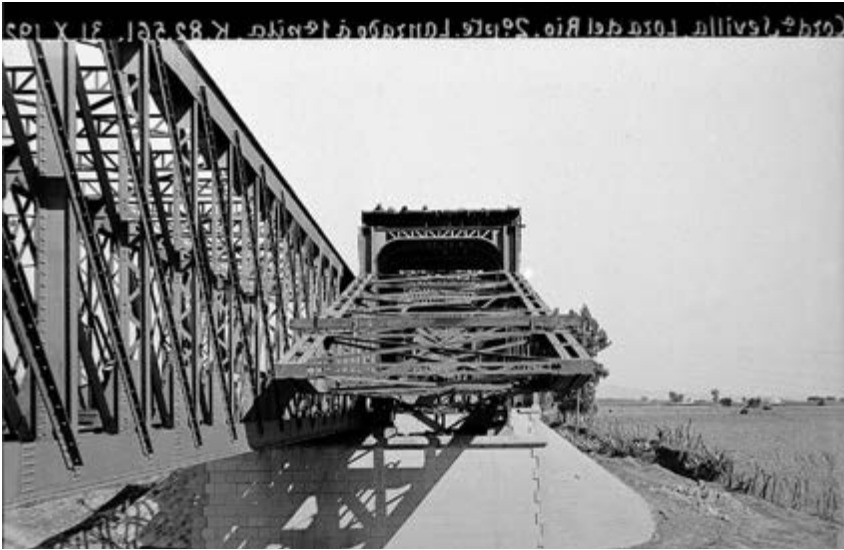
Lanzamiento del nuevo puente sobre el río Guadalquivir, a su paso por Lora del Río, en el p. k. 82,561 de la línea Córdoba-Sevilla. Año 1929.
