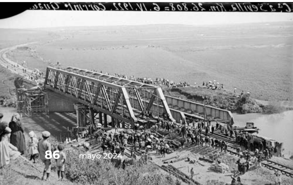
Gran expectación en el corrido del nuevo puente metálico sobre el río Guadiato, en el p. k. 26,808 de la línea Córdoba-Sevilla, término cordobés de Almodóvar del Río el 6 de abril de 1922.
