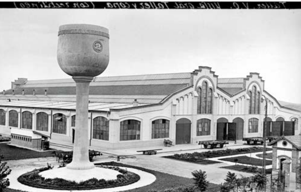
Taller Central de Vía y Obras de Villaverde Bajo (Madrid), recién finalizadas las obras. Año 1924.
