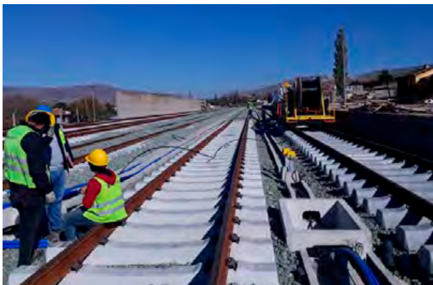
► Tramo ya renovado de la línea Samsun-Kalin (Turquía).
