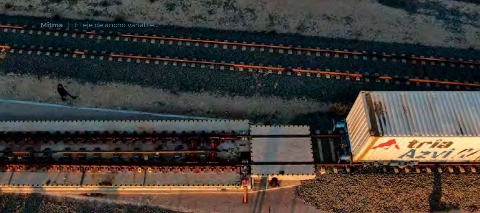
► Vagón a vista de dron en La Gineta.
