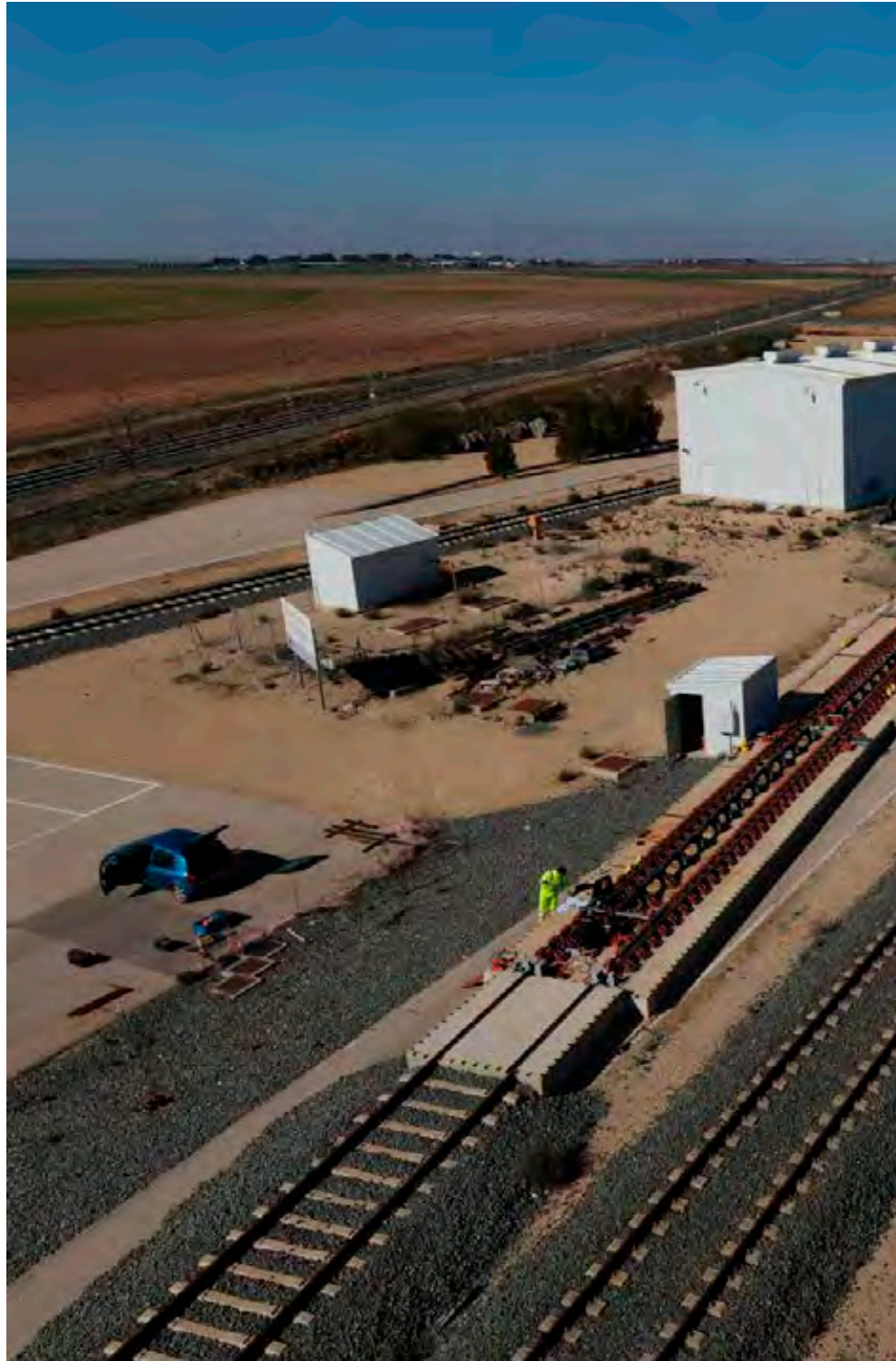
► El proyecto ha incluido la construcción del cambiador de ancho en la base de montaje de vía en La Gineta.
