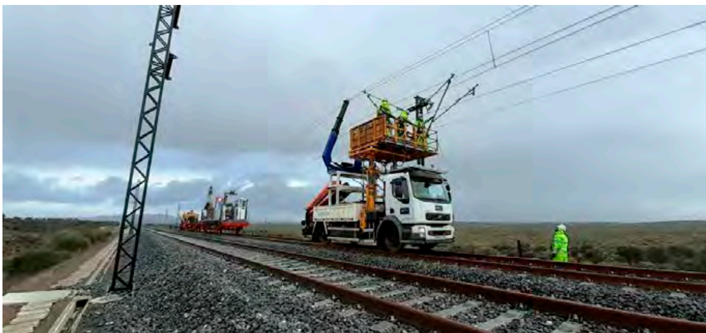
► La electrificación favorece la descarbonización del sistema ferroviario. En la imagen, tendido de catenaria en el tramo Plasencia-Cáceres. ADIF
