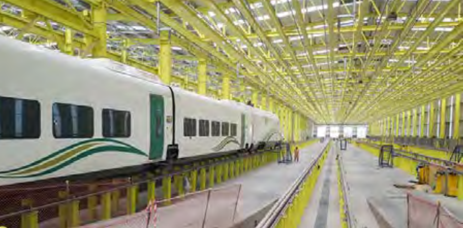
Los dos talleres de mantenimiento de la línea han sido co diseñados por Renfe. CONSORCIO ESPAÑOL ALTA VELOCIDAD MECA MEDINA
