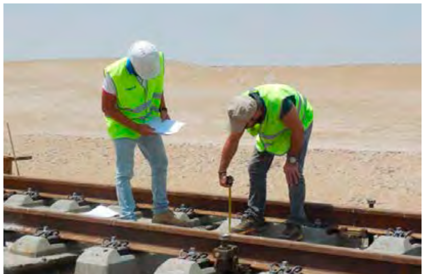
► Montaje de vía de la línea Meca-Medina (Arabia Saudí).
