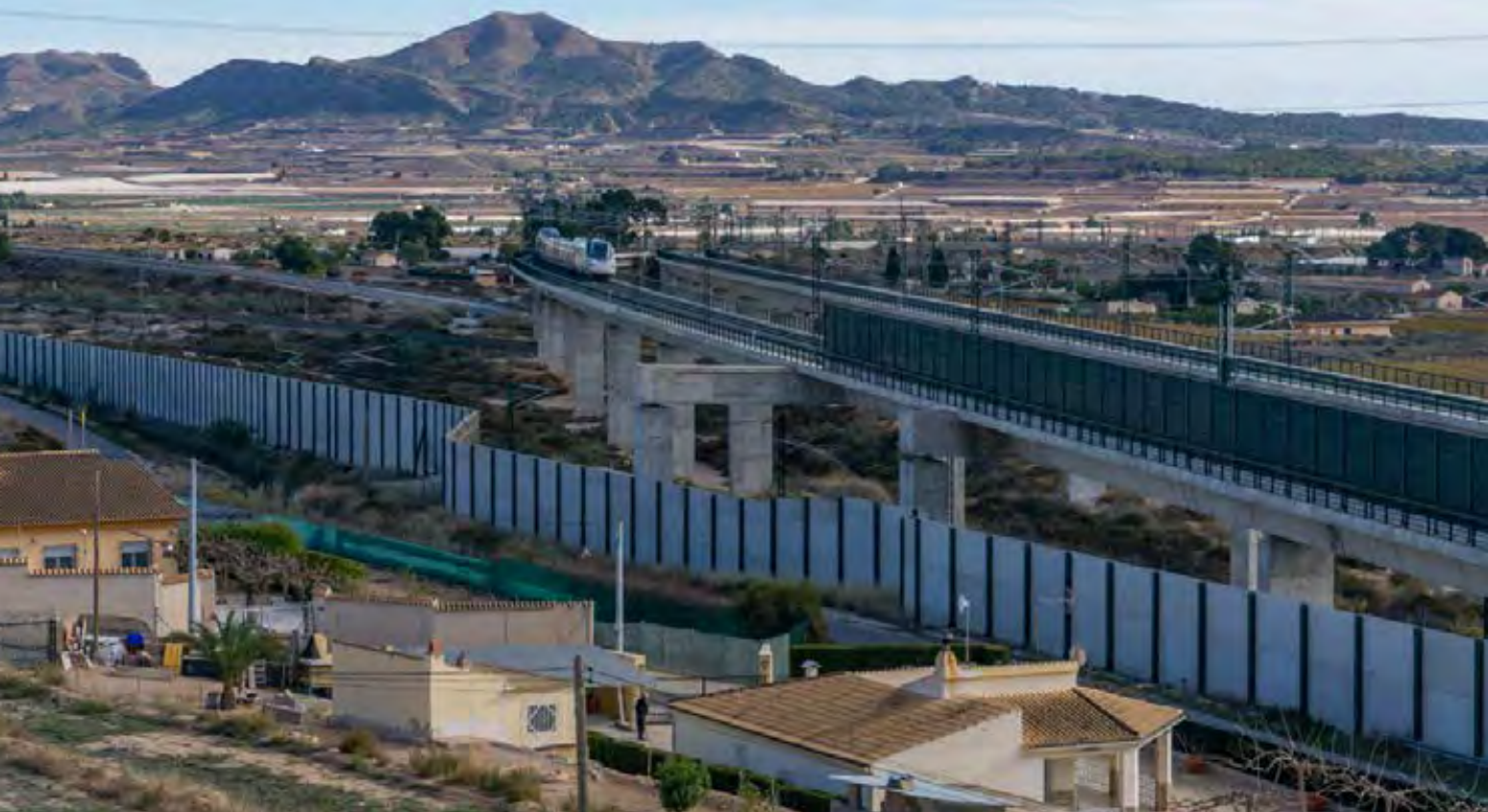
► Línea de Alta Velocidad San Isidro-Murcia.
