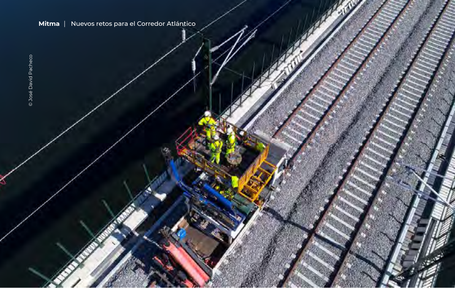
► Trabajos de electrificación en la LAV Madrid-Extremadura.
