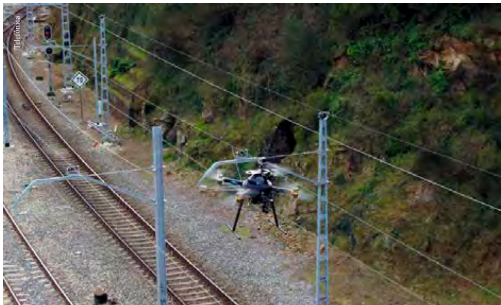
► El uso de drones y tecnología 5G evita el desplazamiento de personal y permite observar lugares inaccesibles.
