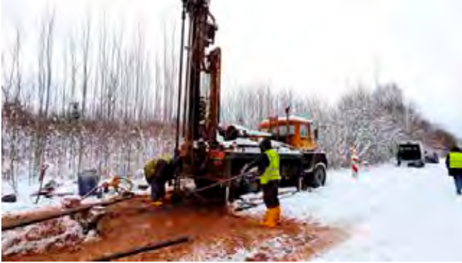
► Sondeo del terreno en el tramo Letonia Norte de la futura línea Rail Baltica.
