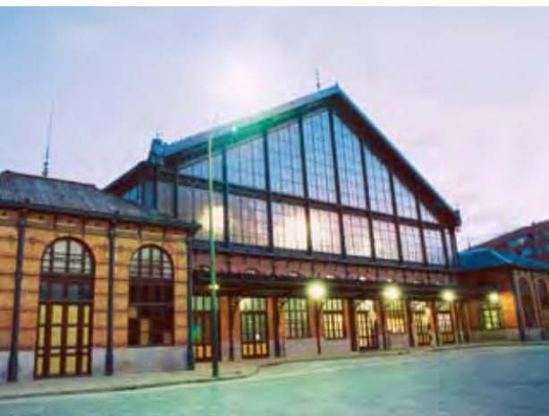
Fachada actual de la estación.
