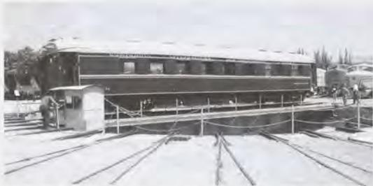
El puente giratorio es uno de los elementos más característicos de un depósito de tracción a vapor. Su función es cambiar la orientación de las locomotoras, así como colocarlas en la vía más adecuada de la rotonda. Todas ellas confluyen en el puente giratorio que, a su vez, está conectado con las vías de la estación de Vilanova.
