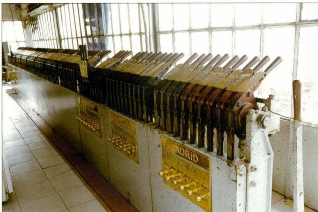
Enclavamiento hidráulico de Algodor, cedido al Museo por la UN de Mantenimiento de Infraestructura.
