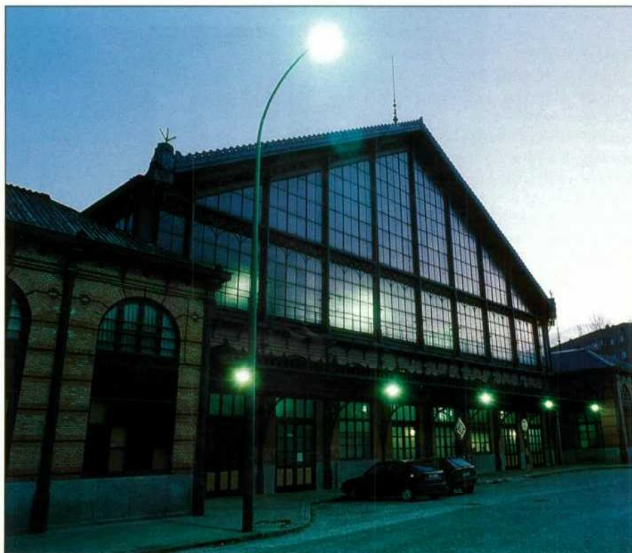
El Museo habilitará una sala dedicada a la infraestructura ferroviaria.
