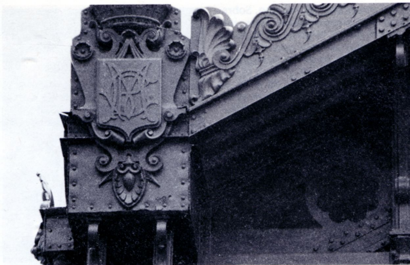
En el ángulo izquierdo de la fachada de Delicias aparece, trenzado en bella labor de forja, el anagrama Madrid-Cáceres-Portugal, la compañía a la que, en definitiva, sirvió como estación de cabecera.
