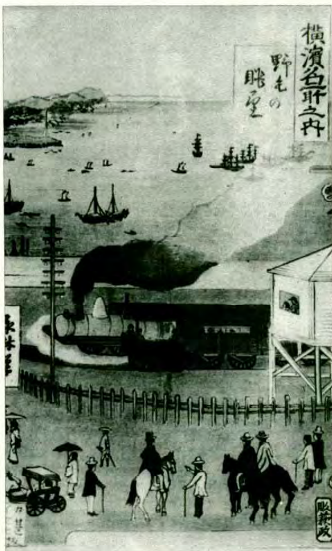
Llegada del primer tren de ferrocarril a Yokohama, según un grabado de la época.
