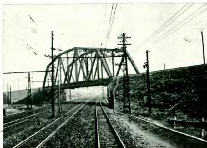
Línea de Tokio a Yokohama. Obsérvese el ancho de vía que, pese a ser de sólo 1,06 metros, permite también grandes velocidades.
