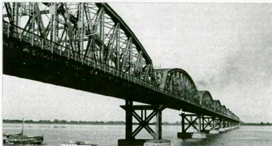
El gran puente de Hardinge sobre el río Padma. Es el puente de mayor longitud de Bangla-Desh, con sus 1.600 metros. La fotografía está obtenida antes de que fuera volado por las tropas del Pakistán, en 1971.
