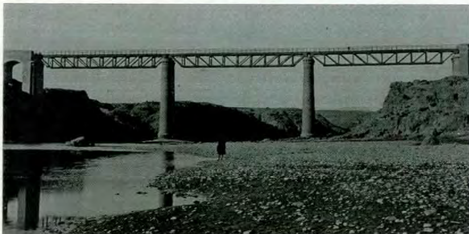
Puente de Haro en las proximidades del Peshawar, punto de máxima penetración hacia el Norte de los ferrocarriles de la India durante muchos años.
