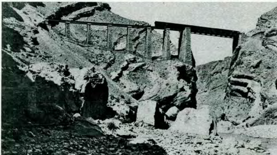
El viaducto Luisa-Margarita, el más importante de la línea de Quetta. Consta de siete tramos de 10 metros y un arco central de 37,50 metros.
