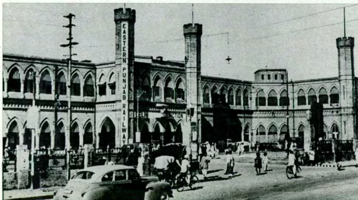
Estación de Delhi. Empalme de la compañía Eastern Punjab Railway. Obsérvese el curioso estilo euroasiáticos con influencias góticas y sus curiosas torres octogonales.
