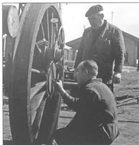
Obreros del depósito de Salamanca calibrando el ajuste de una rueda de locomotora. Año 1967.
