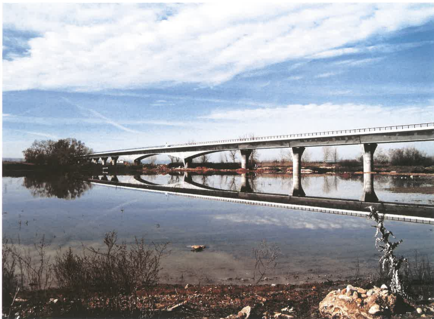
Viaducto del AVE, tramo Mocejón-Toledo.
