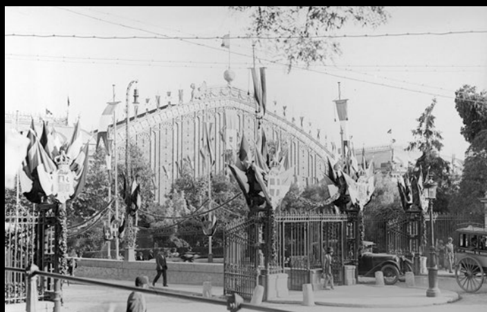
Estación de Atocha engalanada para la visita de los reyes de Italia, Víctor Manuel III y Elena de Italia, el 9 y 10 de junio de 1924.
