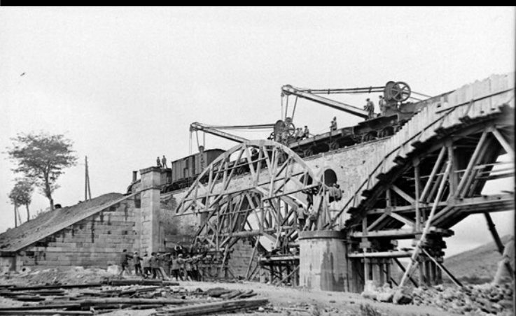
Colocación de cimbras con ayuda de grúas móviles, en la construcción del puente sobre el río Guadalmez, pk 289,182 de la línea Madrid a Badajoz. 1927.
